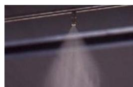
• **Sistemas de nebulización:** Recomendados por la guía del INS para entornos laborales con exposición a SCR, consisten en rociar finas partículas de agua en el aire para humectar y atrapar el polvo de sílice. El agua nebulizada atrapa las partículas de sílice en el aire,
